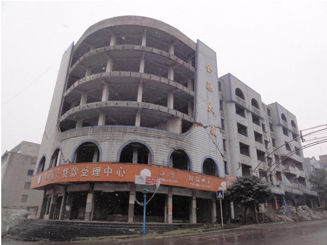
↑ 放置されたビル
