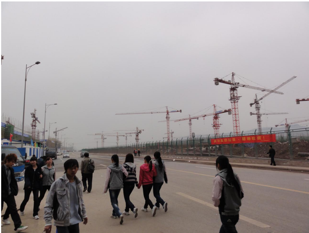
↑ 道路の両側で新工場の建設が同時並行的に進む。工員はみな若い。
