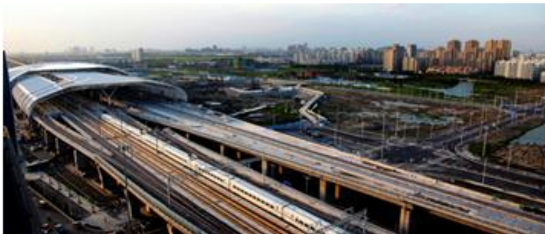
↑ 昆山南駅。手前が上海－南京線、奥が北京－上海線。
