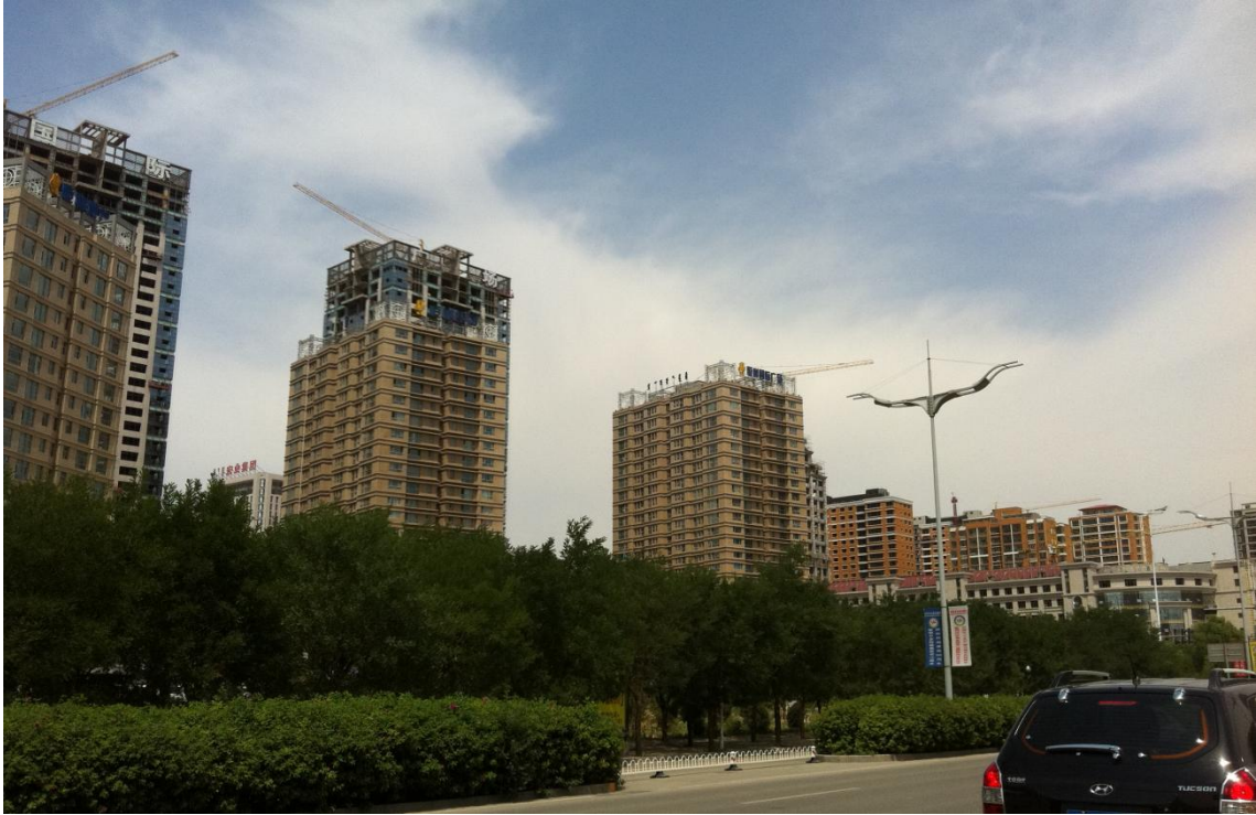
↑ 市内は至るところでビルが建設中である。
