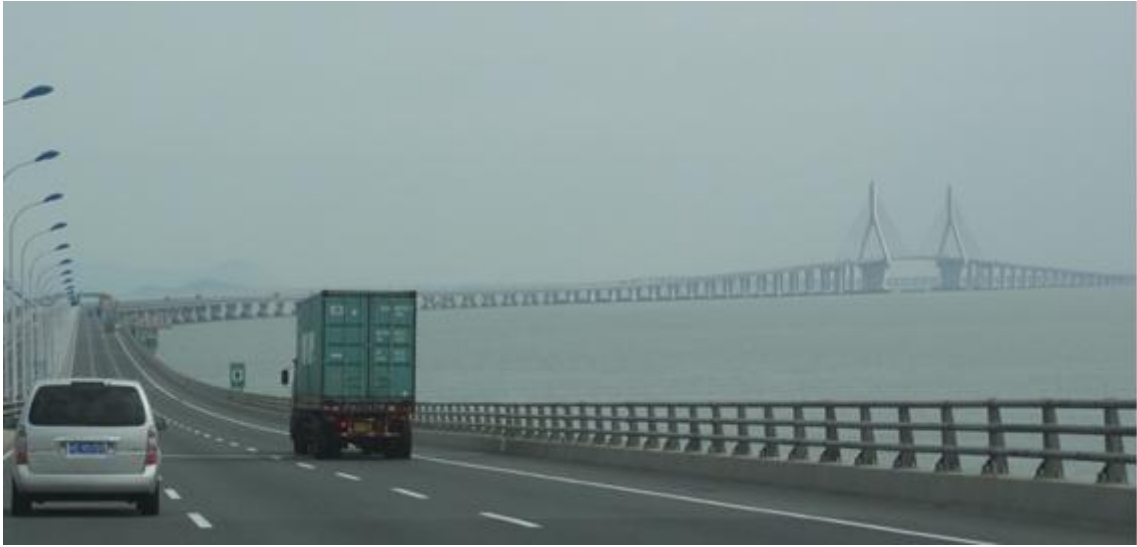
↑ 30km以上にわたり海上のハイウェイがつながる接続道路「東海大橋」。
