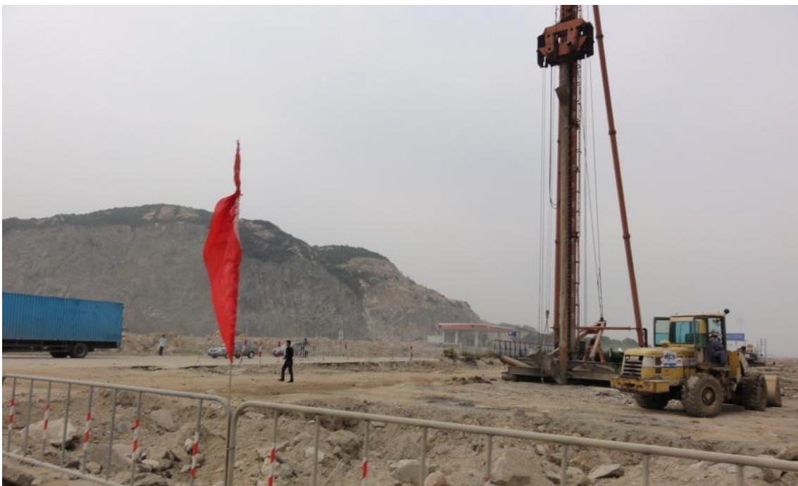
↑ 島全体が工事現場だ。
