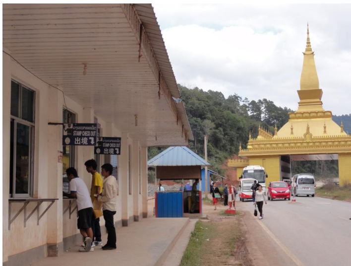
←木造平屋建ての質素なラオス側国境ゲートビル（左）と、現在建築中の新国境ゲートビル。
