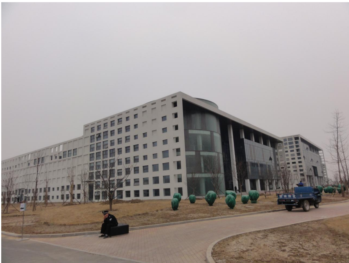
↑ 建設されたばかりの貸し工場。(天津市武清開発区)
