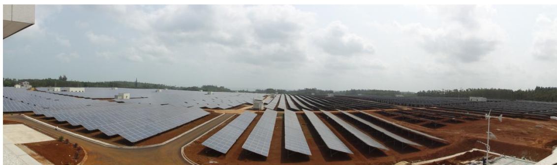
↑ 20MW 規模の太陽光発電所。非常に大きな土地が必要だ。
