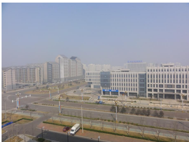
関係政府機関や従業員寮の建設が進んでいる
