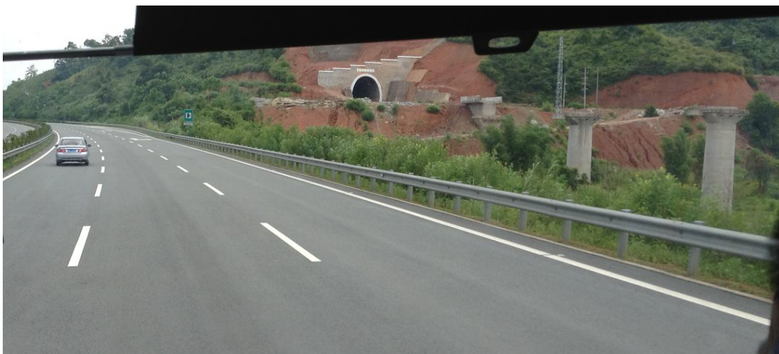
↑ 高速鉄道建設現場 (江西省贛州市)
