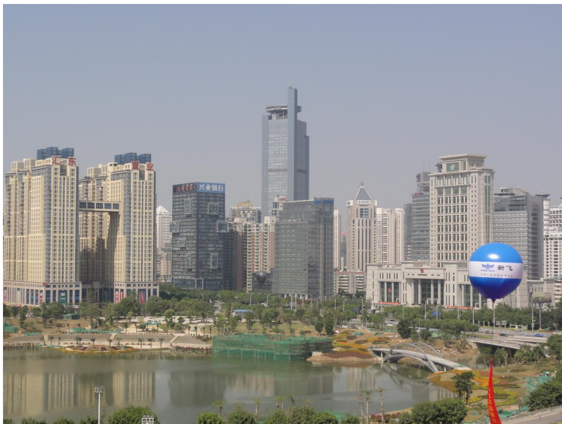
↑ 広西チワン族自治区の区都「南寧」の新市街地。
