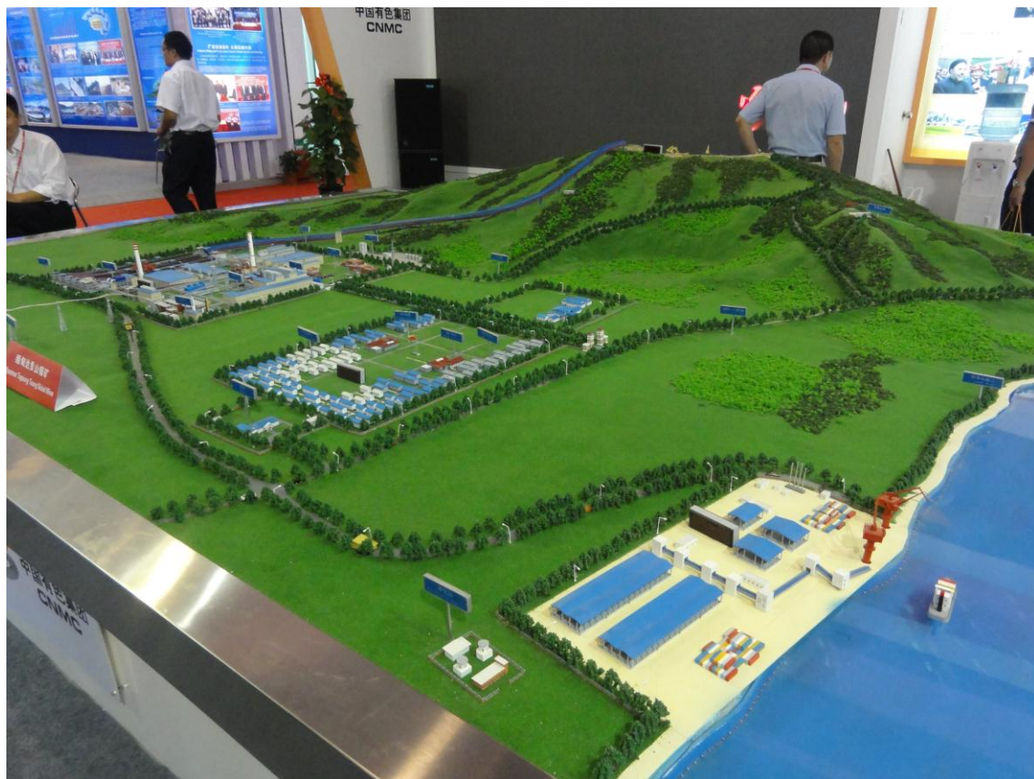
↑ 鉱山（奥）から製錬所、港湾（手前）まで一貫した中国有色によるミャンマーの達貢山ニッケル鉱山の模型
