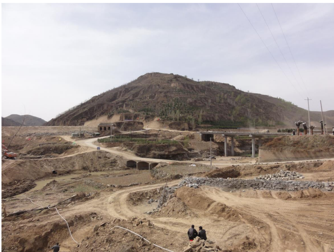
↑ 梁家河村に入るための橋（手前）。新しい橋（後ろ）への架け替え作業中。
